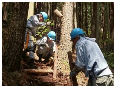
杭打ちは、狙いを定めて。
