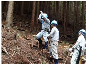
杭打ちは、狙いを定めて。
