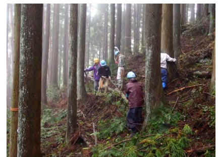
濡れた傾斜地の作業は要注意！
