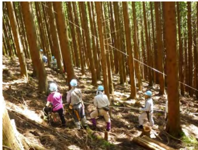
ロープを引く時は伐倒木に注目！
