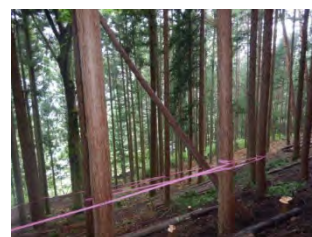
立入禁止措置実施の様子
