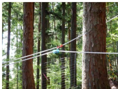
動滑車設置状況(近景)
