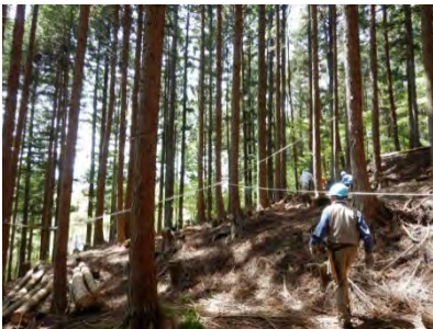
動滑車設置状況(遠景)
