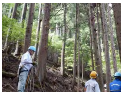
急斜面での作業は注意して!
